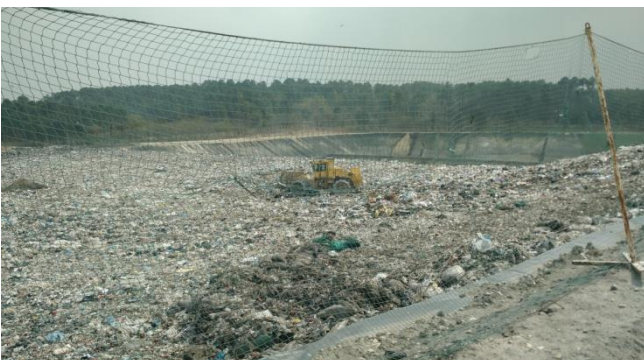
Casier de stockage en plein remplissage
